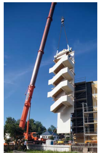
▶ Den Abschluss des Projekts bildeten die Fassadenarbeiten und der Bau der Treppenhäuser
