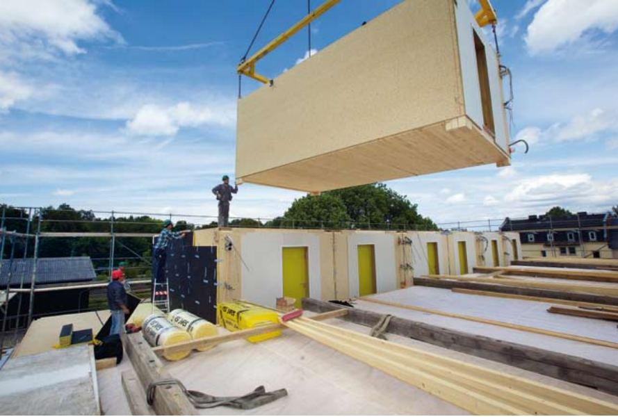
◀ Bett und Dusche, WC und Handtuchstange, Schränke und Duschtrennung, Schreibtisch und Türen – so vollständig kamen die Container bereits an der Baustelle an
